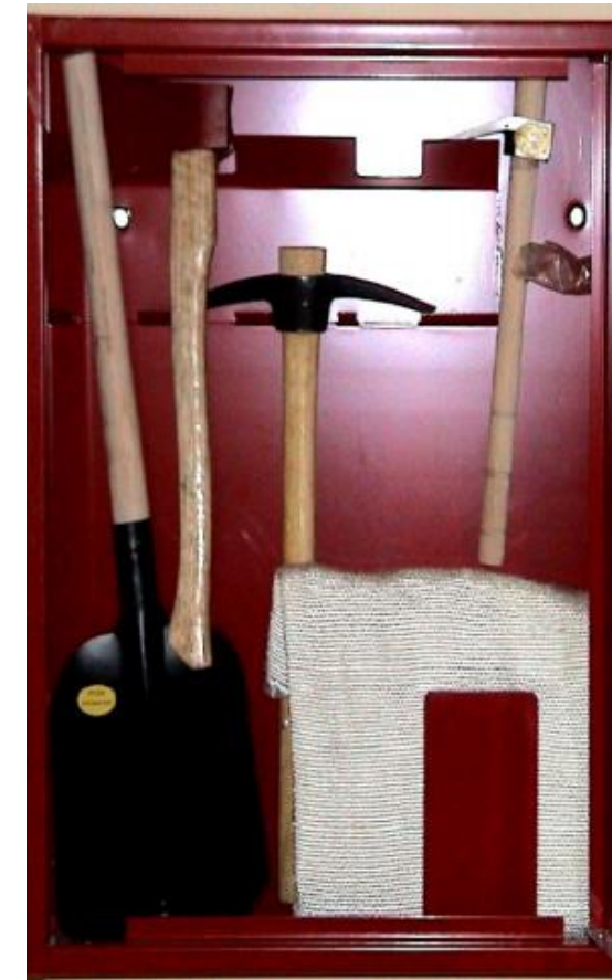
ΣΤΑΘΜΟΣ ΠΥΡΟΣΒΕΣΤΙΚΩΝ ΕΡΓΑΛΕΙΩΝ
